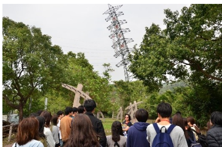
図1 地震で傾いた鉄塔
