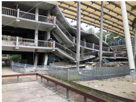
地震で壊れた校舎（中）
